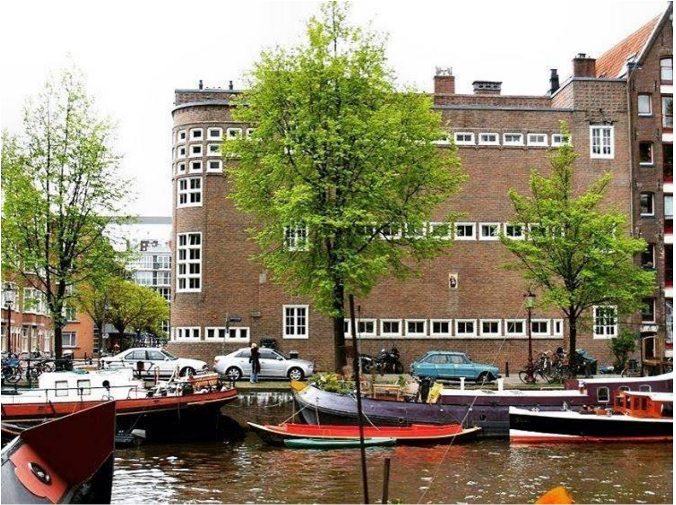
(ons schoolgebouw, gezien vanaf De Oudeschans)
